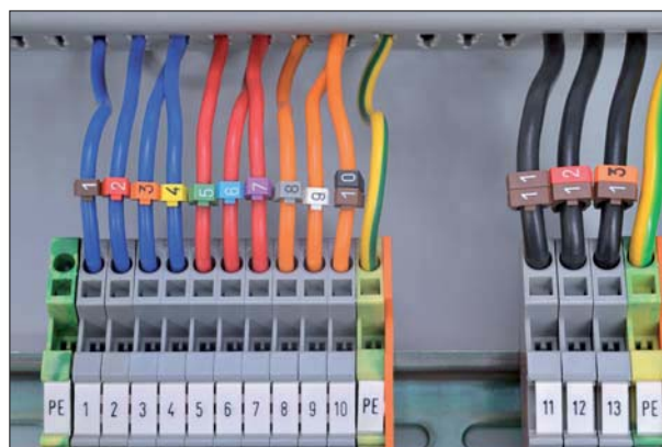
Un moyen simple d'identifier clairement les câbles après montage.
