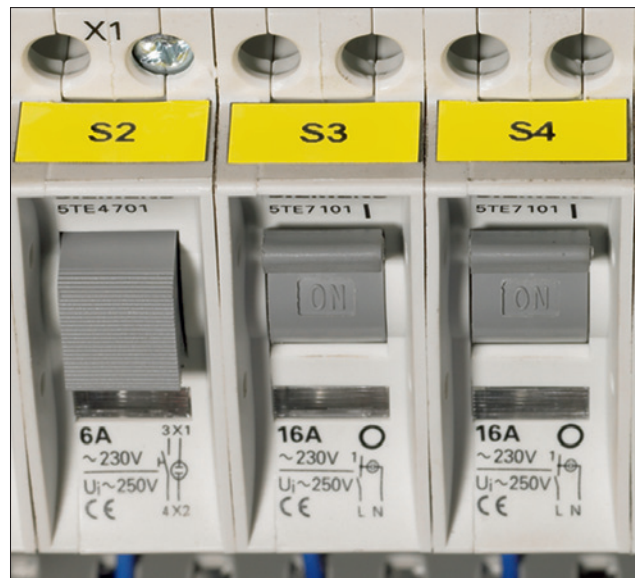
Helatag-Laser-Etiketten ermöglichen die einfache und schnelle Kennzeichnung von Schaltschränken.
